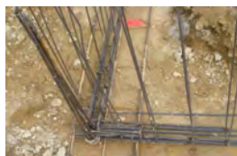
Nœud de chaînage - Continuité mécanique
