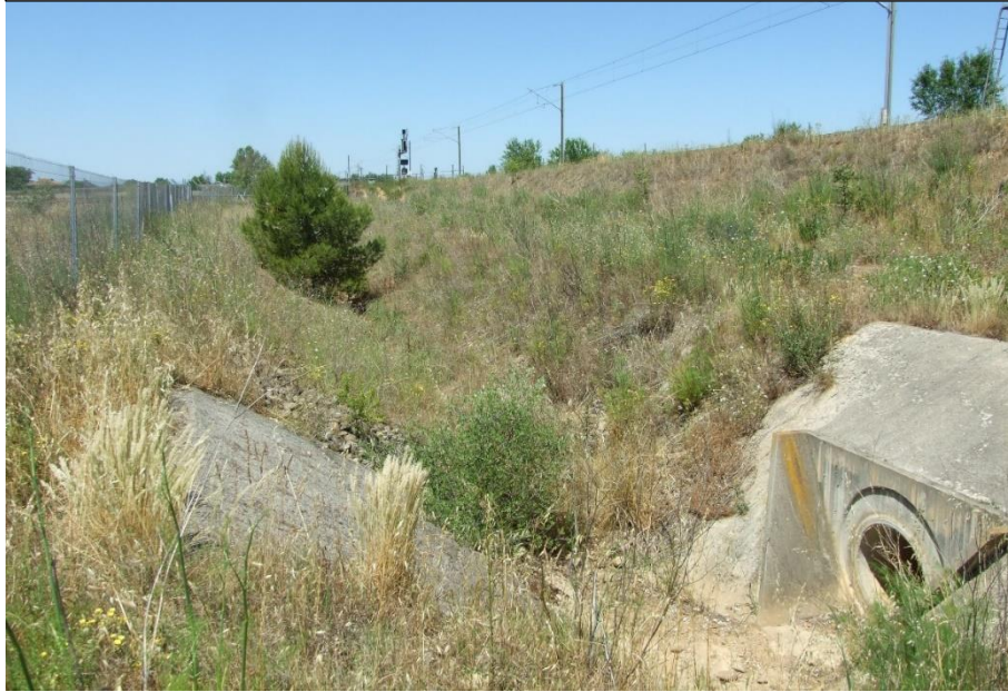
Ouvrage de connexion fossé reprofilé LGV / fossé ligne Fret / OHR RE081-1 (DN1200)
