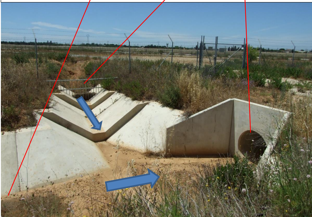
Ouvrage de connexion fossé reprofilé LGV / fossé ligne Fret / OHR RE081-1 (DN1200)
