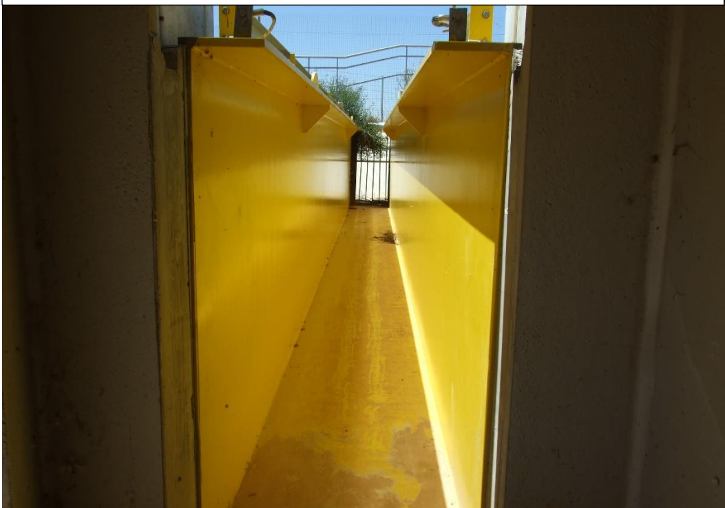
Corniche métallique (canal 90 x 155, permettant la traversée de la tranchée Manduel
