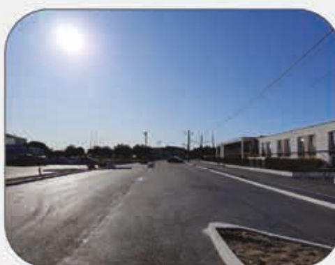
Aménagement du parking de l'école F. Dolto
