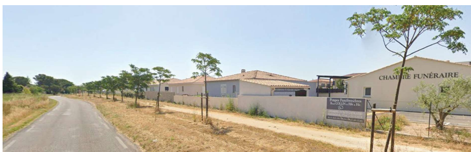
Entrée Ouest de Manduel par la Route de Rodilhan, quartier de Cante Perdrix
